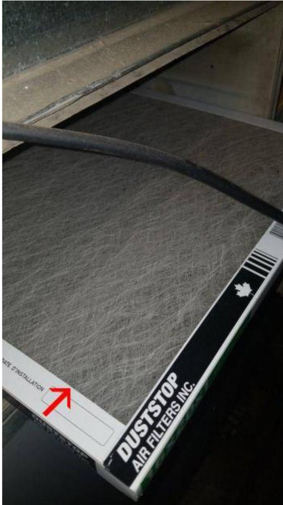
Lors de notre inspection nous avons observé le filtre à air et nous avons constaté aucune anomalie. Nous vous recommandons de les et/ou le vérifier et de le nettoyer régulièrement et/ou de changer le filtre à air jetable afin d'assurer une bonne circulation.
