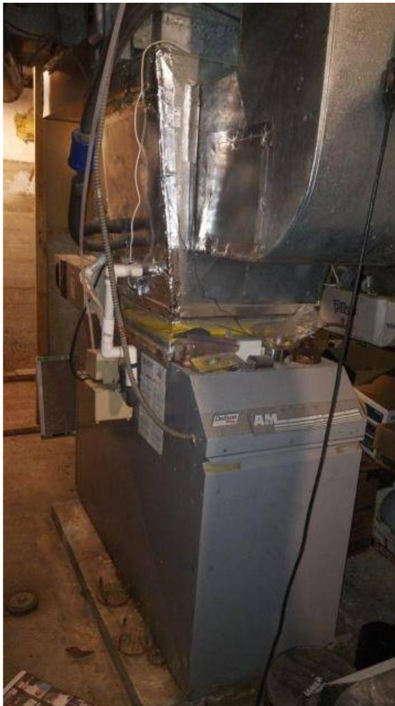
Lors de notre inspection nous avons observé que la propriété est chauffé par une fournaise à l'huile à air pulsé et une thermopompe est branchée sur la fournaise, et à été mise en marche, et nous avons constaté aucune anomalie. Nous vous recommandons de vérifier auprès d'Hydro-Québec si le propriétaire actuel bénéficie d'un tarif réduit associé à la bi-énergie.
